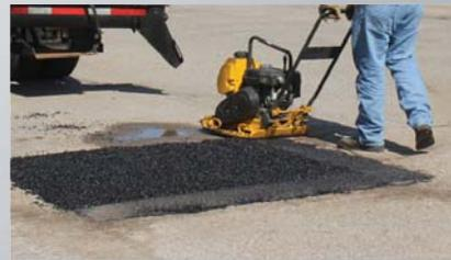
El bache ya reparado estará listo para el tráfico y el sistema InPave™ opcional recopilará la información de la ubicación, la bacheadora y el material aplicado y lo cargará en el Sistema de Administración de Bacheo InPave™.
