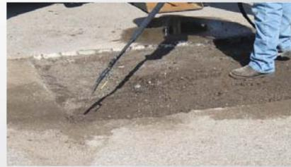
Se aplica una mezcla asfáltica en caliente o en frío en el área de reparación, ya sea mediante el conducto de descarga estándar o el sinfín giratorio opcional.
