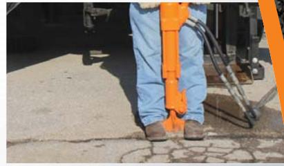
Exclusiva barra de finalidad doble neumática que limpia el bache con aire a presión. La misma barra neumática efectúe el riego de adherencia de manera uniforme.
